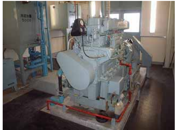
定山溪浄水場（自家発電設備）
