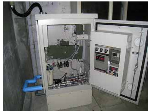
給配水水質自動計器
