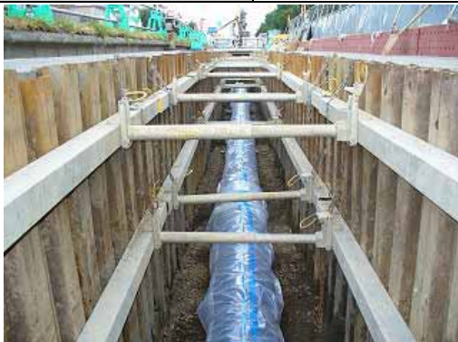
配水管工事の様子
