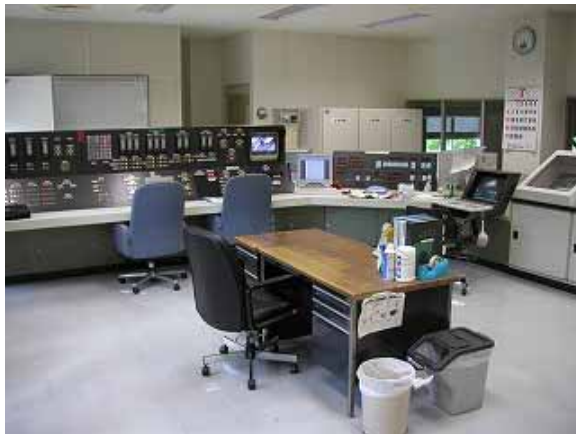
定山溪浄水場（計算機）
