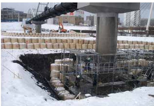
「耐震化工事（水管橋 64 ）」
