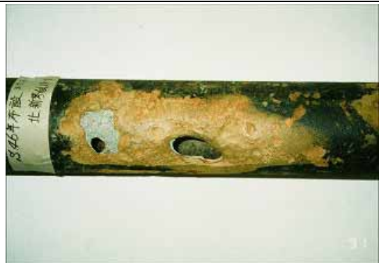
外面腐食により穴が開いてしまった配水管
