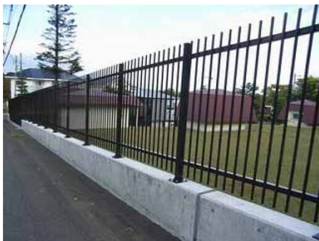
侵入防止対策後の施設（フェンス強化）
