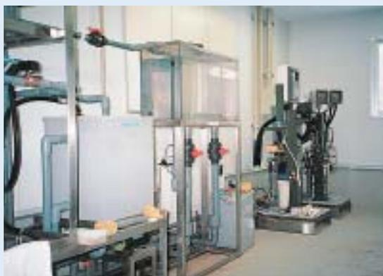
（濁度、pH、電気伝導率などの項目を24時間監視しています）
