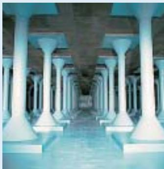
また、配水池は、昼間や深夜など時間によって増減する水の使用量と、浄水場から送られる水量を調整するとともに、適正な水圧を保って安定した給水を行う機能を持った水道水のストック施設です。
