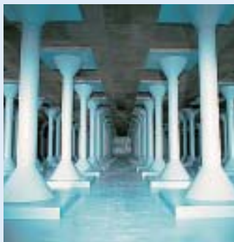
配水池の内部
