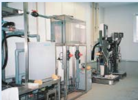
砥山ダム水源水質自動監視所の内部
