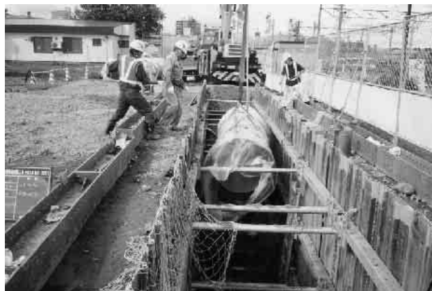
配水管の布設・更新
