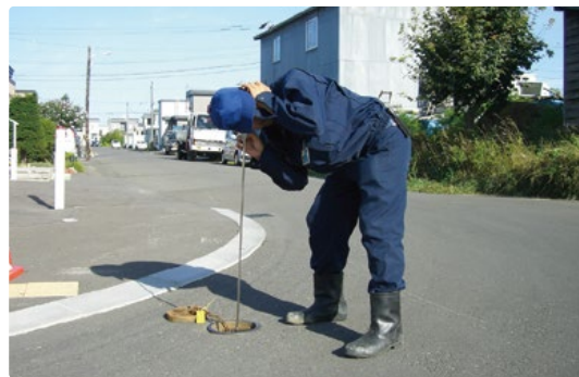
仕切弁の音聴調査
