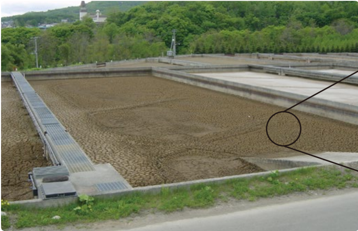
自然エネルギーである太陽熱を利用した天日乾燥床
