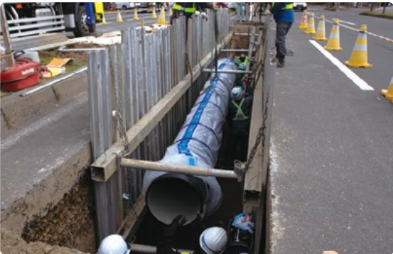
配水管の布設替え
