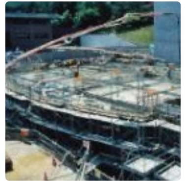
藻岩浄水場改修工事 (平成9～15年)
