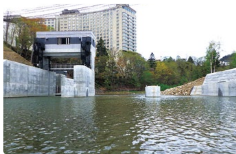
玉川橋取水堰 (豊平川水道水源水質保全事業)
