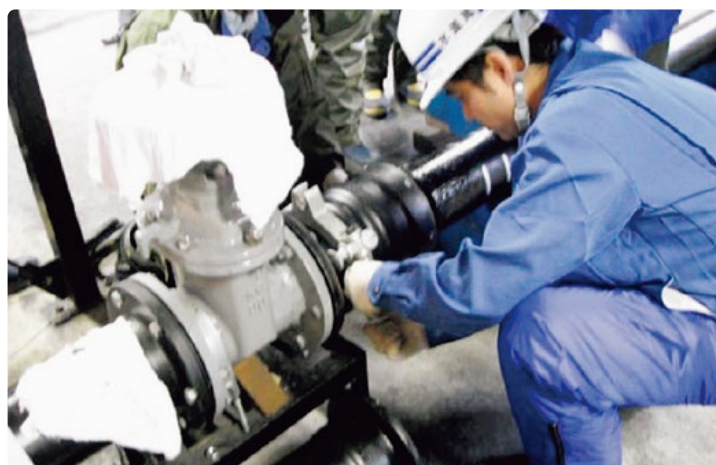
配水管接合実習
