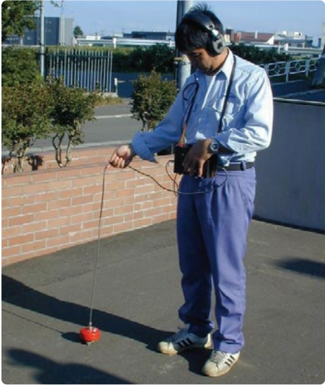
漏水探知機による調査
