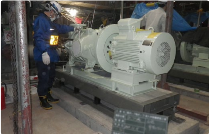
ポンプ設備更新工事
