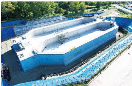
白川新沈砂池の建設（白川浄水場改修事業）
