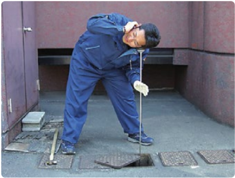
水道メーターの音聴調査
