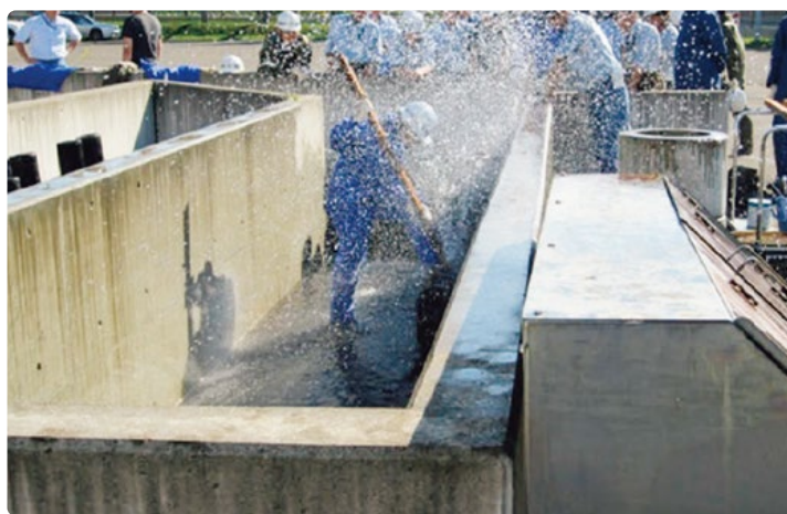
漏水修理実習
