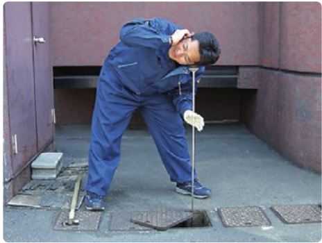
水道メーターの音聴調査
