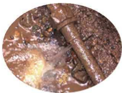
給水管からの漏水の様子
