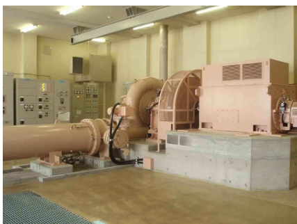
藻岩浄水場水力発電施設
