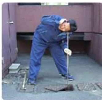
水道メーターの音聴調査
