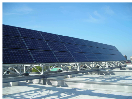
配水センター太陽光発電施設
