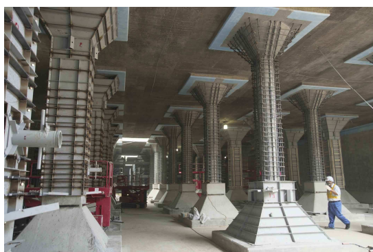
平岸配水池耐震化工事の様子
