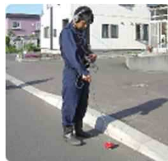
漏水探知機による漏水調査
