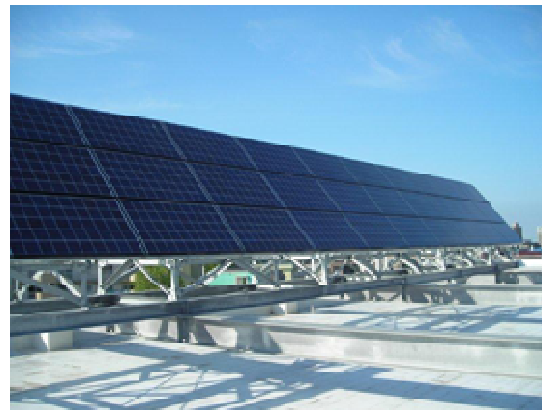
配水センターの太陽光発電設備
