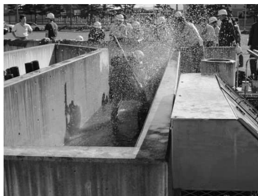
漏水修理実習
