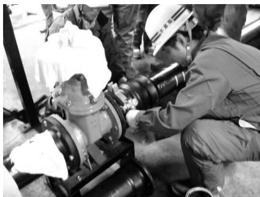
配水管接合実習
