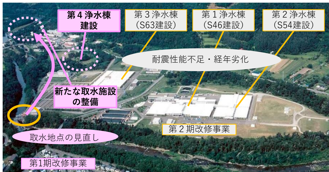
【図表27】白川浄水場の全景
