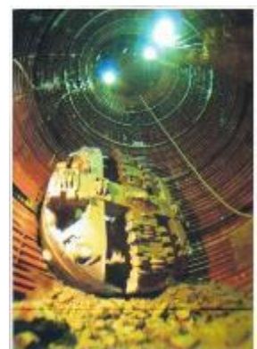
白川第3送水管新設工事 (平成15～令和元年)
