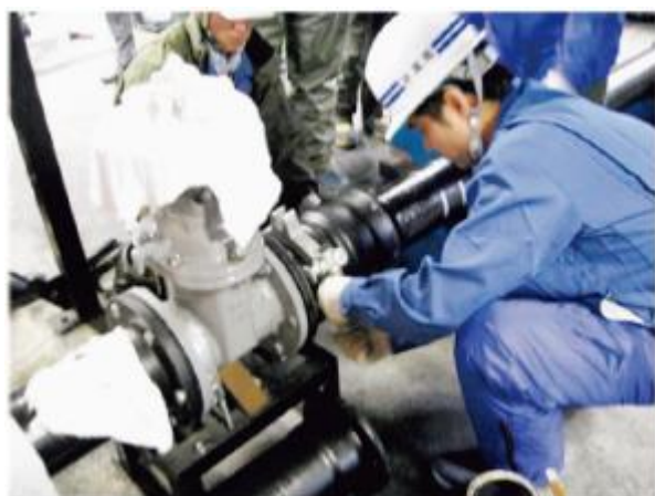
配水管接合実習
