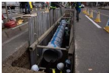
配水管の布設替え
