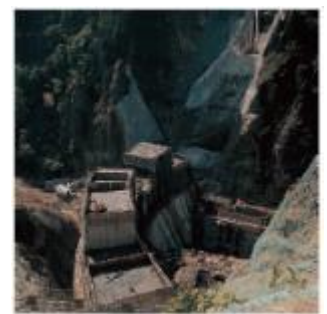
豊平峡ダムの建設
