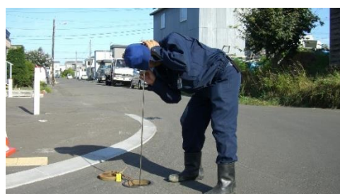
仕切弁の音聴調査
