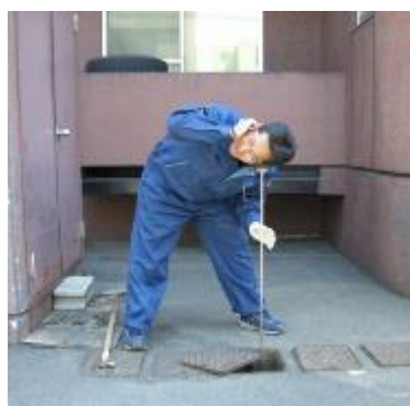
水道メーターの音聴調査
