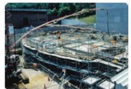
藻岩浄水場改修工事 (平成9～15年)
