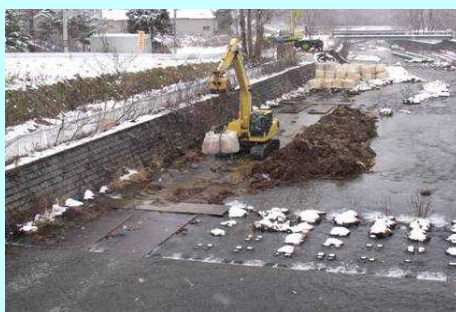
水源事故時の対応 （河川工事の様子）
