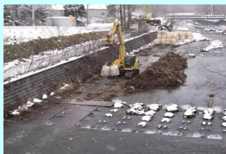
水源事故時の対応 (河川工事の様子)
