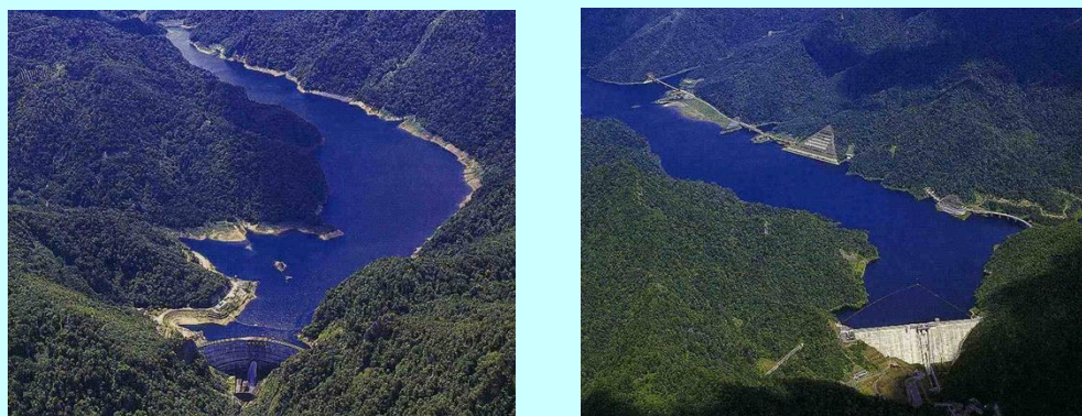
水源のダム（左：豊平峡ダム、右：定山溪ダム）
