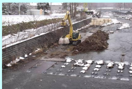
水源事故時の対応 (河川工事の様子)
