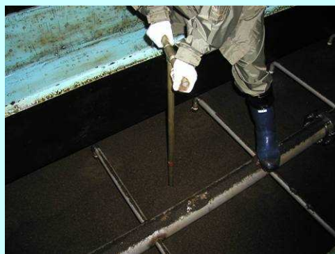
ろ過池調査（調査器具を用いて）
