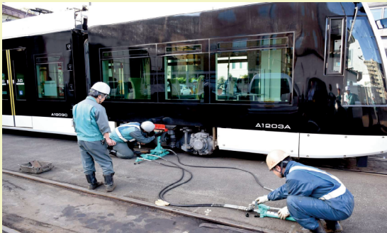
脱線復旧訓練
