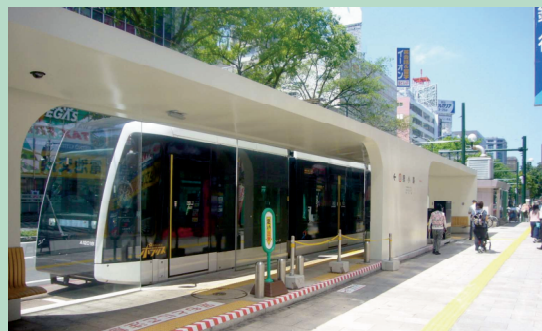
ループ化に伴い新設した狸小路停留場
