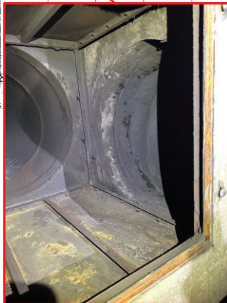
点検口開口時
