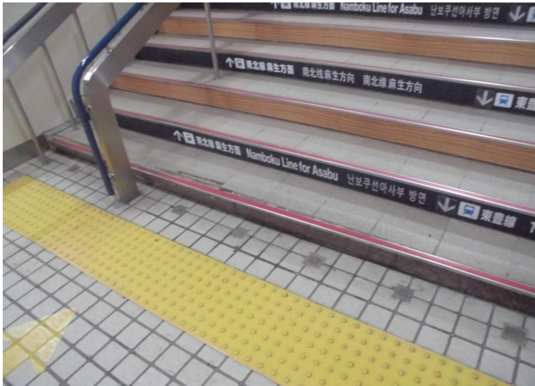
参考：南北線階段部現場写真
