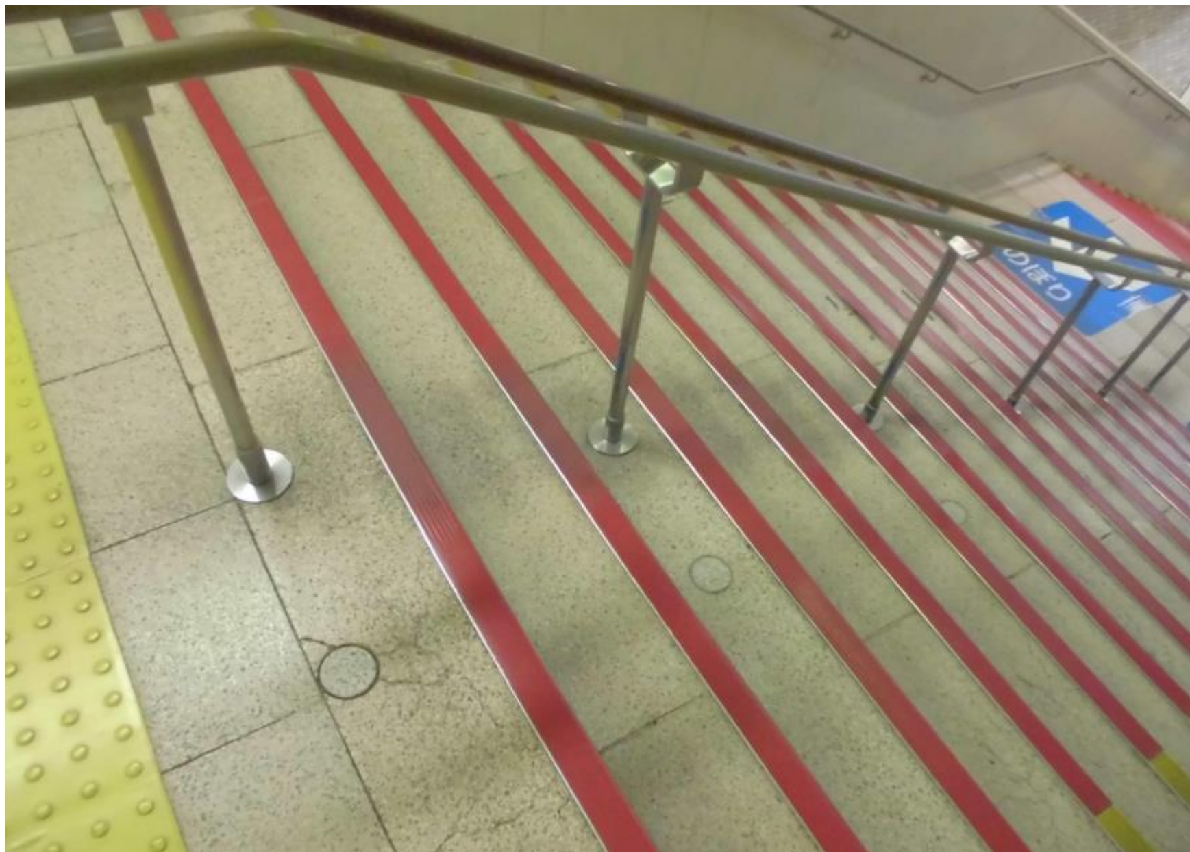
参考：東西線階段部現場写真
