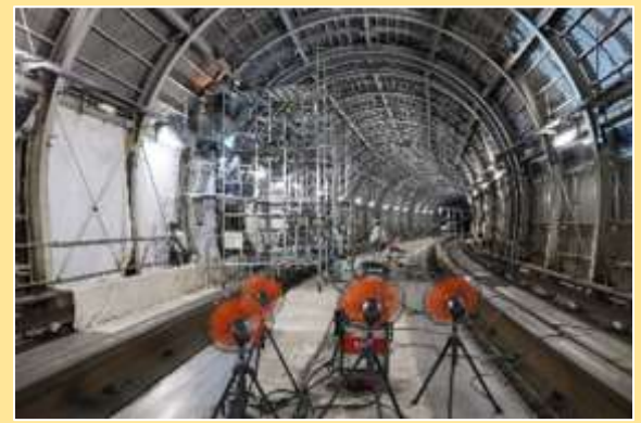
シェルター耐震改修工事
