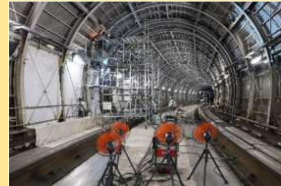
シェルター耐震改修工事
