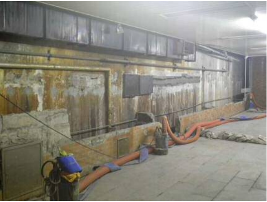
連絡通路南側 止水作業完了後
