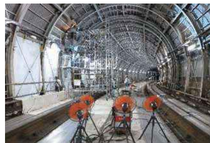
南北線シェルター工事の様子
