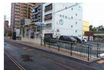
東本願寺前停留場(内回り) 改修後
