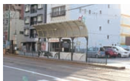
東本願寺前停留場(内回り) 改修前
