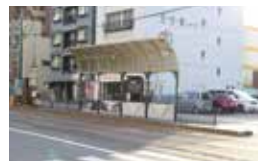
東本願寺前停留場（内回り）改修前
