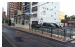
東本願寺前停留場（内回り）改修後
