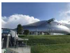
屋外エスカレーター 新設
