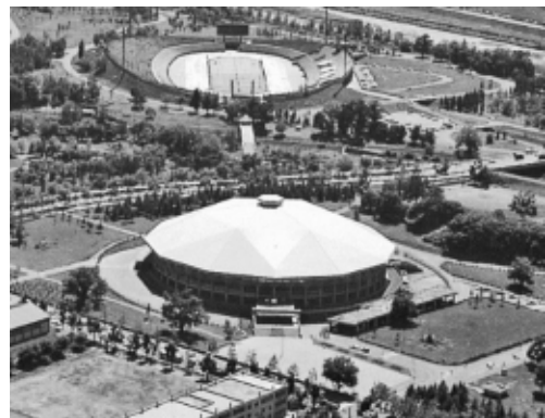
1972年大会時の 真駒内公園屋内競技場
