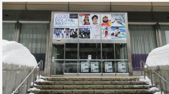
札幌市役所本庁舎 北側風除室
