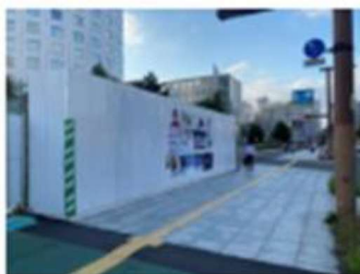
中央区役所解体現場
