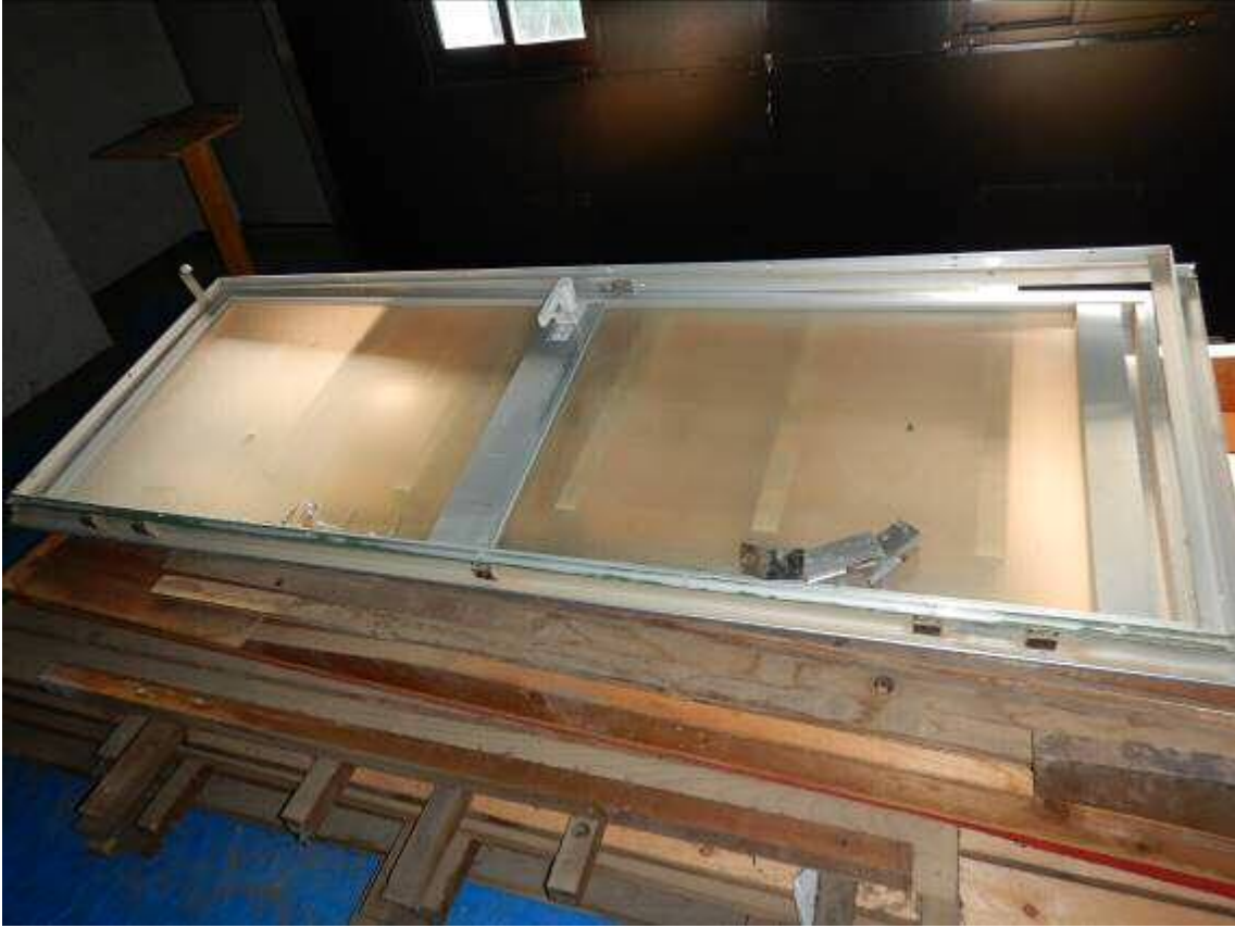
状況写真 既存ドア
