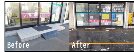
小規模店舗等のバリアフリー改修の事例（店舗入口の段差解消）
