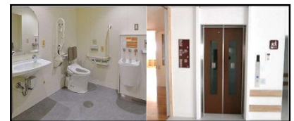
学校へのトイレやエレベーターの設置状況
