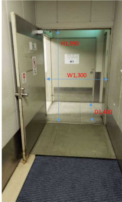
②搬出入経路からEVホール
