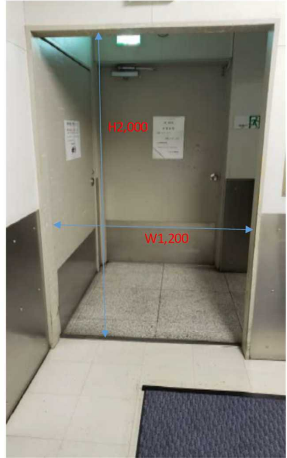
③搬出入経路からEVホール
