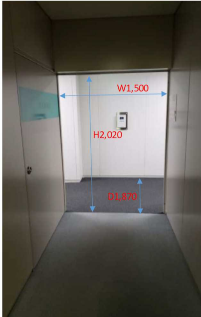
⑤搬入EVホールから16F廊下
