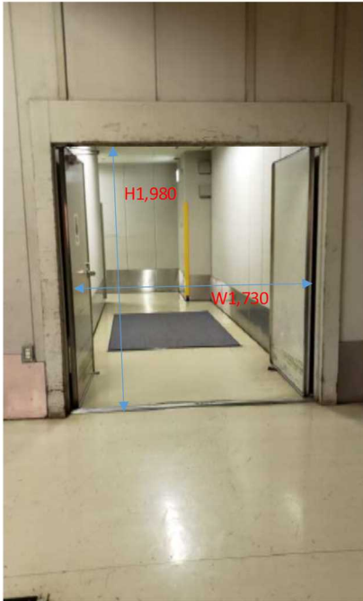
①トラック駐車スペースから搬出入経路
