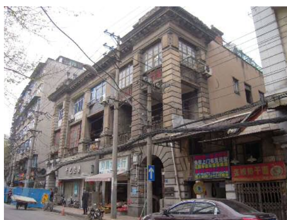
店舗・住宅(現 洞庭街91-97号)
