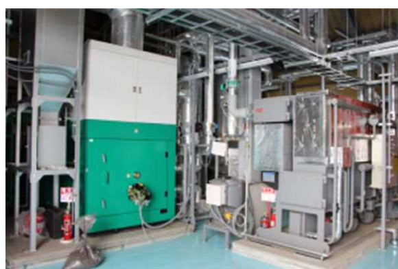
図 7-2-6 エネルギーステーションの木質チップボイラー
