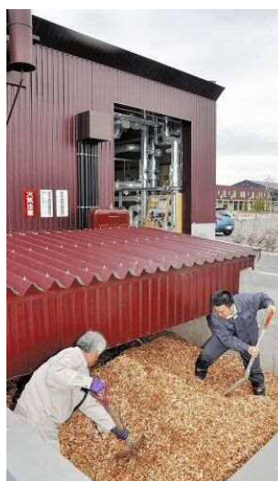
図 7-2-6 エネルギーステーションの木質チップボイラー
