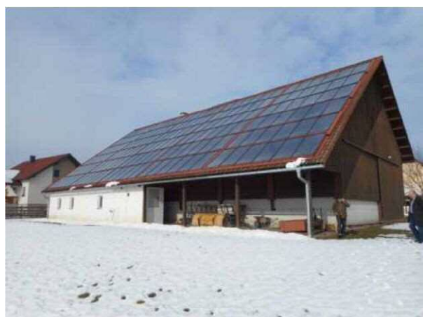
図7-7-6 ウアバースドルフ地区の熱供給施設 (太陽温水器を屋根に装備したチップ倉庫とボイラー室)
