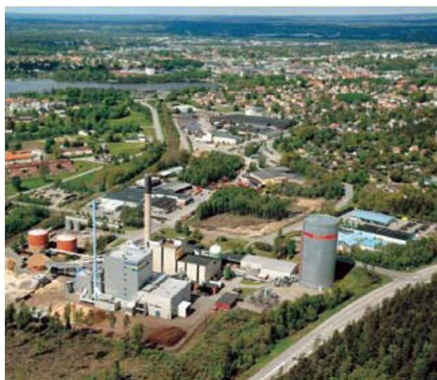
図 7－6－3 熱供給プラント概観
