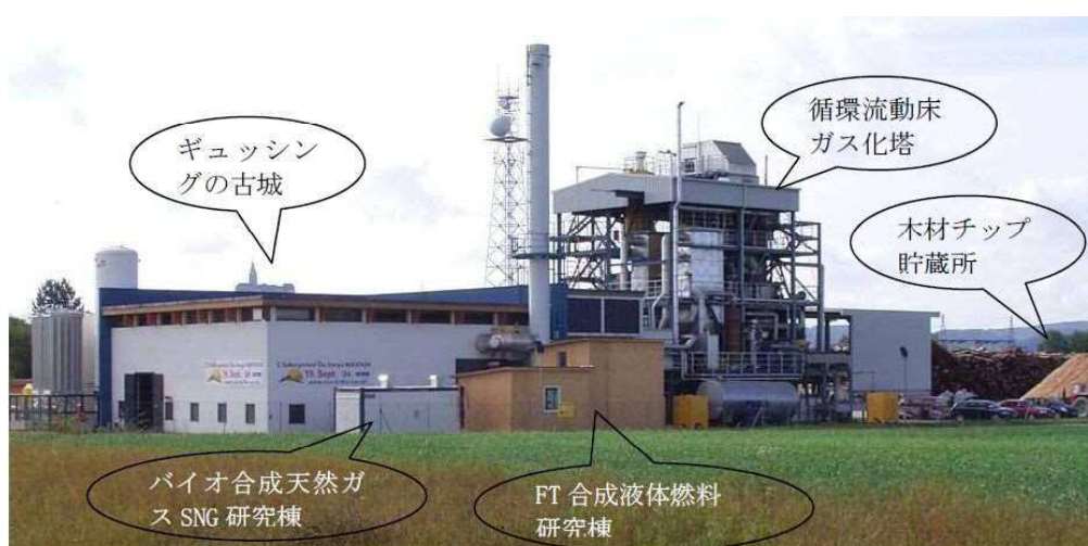
図 7-7-4 ギュッシング市8MW 循環流動床ガス化施設等
