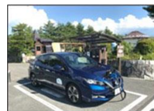
道の駅でのEV充電器の設置
