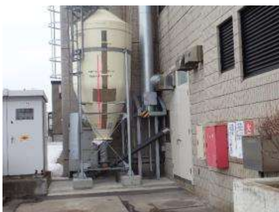
図 3-5 : 左 ペレットサイロ、右 ペレットボイラー
