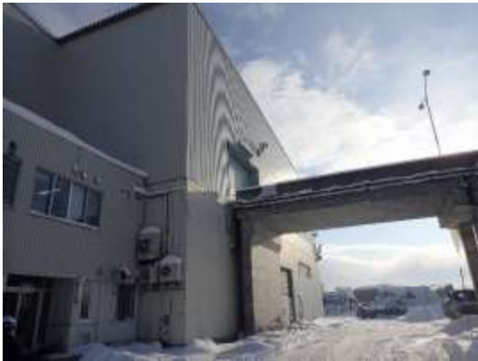
資源化工場 搬入スロープ
