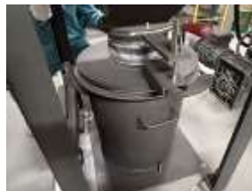
集塵機と集塵機下の灰箱 ボイラー側面の灰箱
