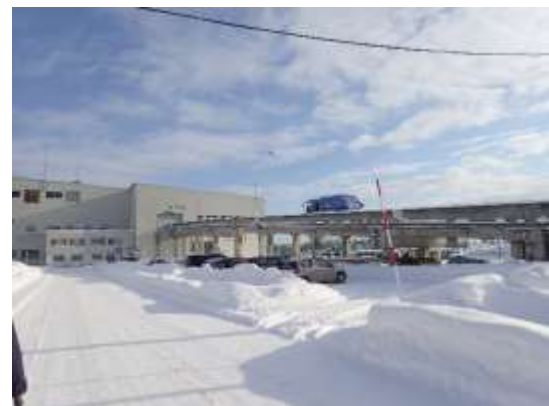
資源化工場への搬入スロープ
