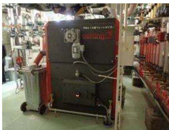
図 3-5 : 左 ペレットサイロ、右 ペレットボイラー
