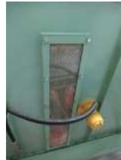
屋内サイロの 残量確認窓
