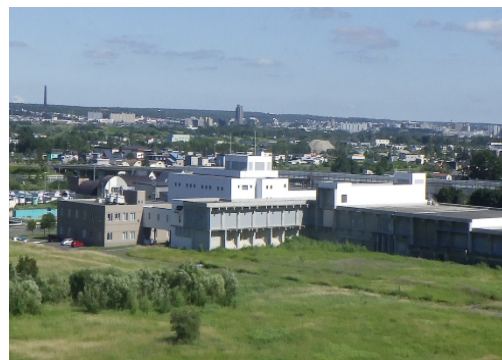
東部水再生プラザ
