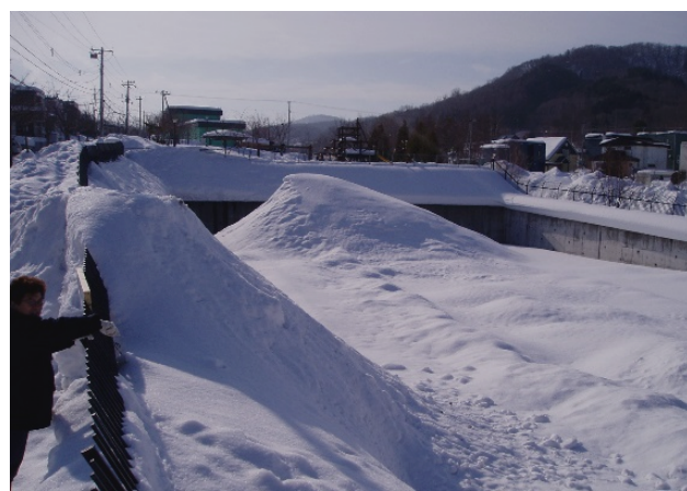
雨水貯留池の活用
