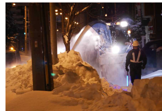
歩道の新雪除雪
