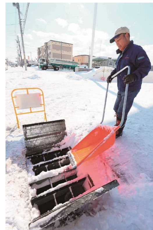
流雪溝に投雪している様子
