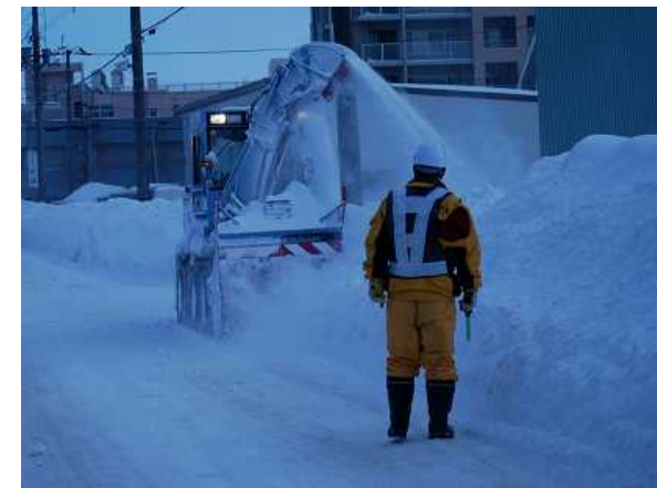
拡幅除雪の作業状況
