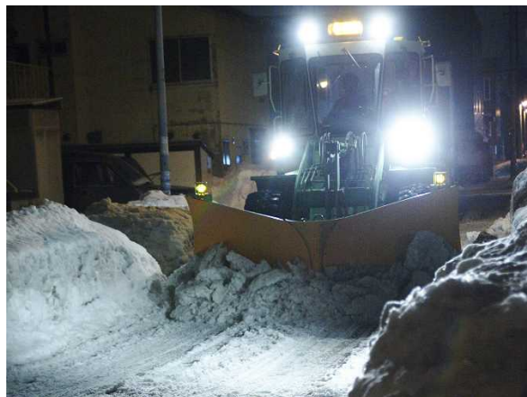
路面整正の作業状況
