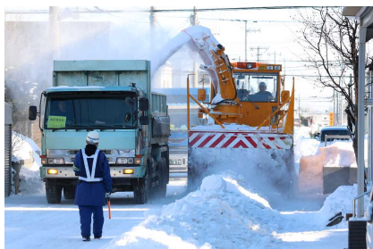
生活道路の排雪作業
