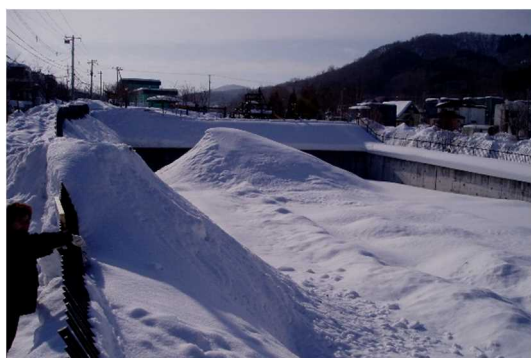
雨水貯留池の活用
