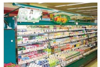
陳列棚ごとの照明を外し、上から照らすだけの方法に変えることで20%近い節電に成功。
