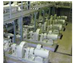
手稲区の曙ポンプ場のポンプ設備。夜間運転により、日中の消費電力を削減する。
