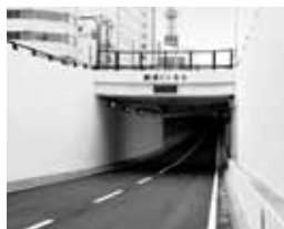
↑平成21年に開通した 創成トンネル
