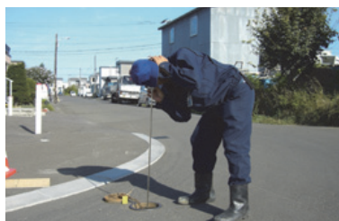
▲音聴調査の様子。路上の仕切弁に「音聴棒」を当て、音を聴いています
