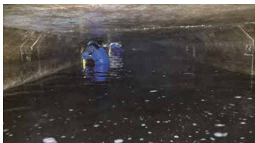
▼下水道管の内部に人が入り調査を行う様子
