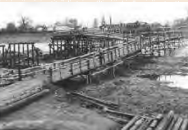
▲3度目の建設中の幌平橋（1953年撮影。札幌市公文書館所蔵）
