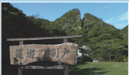
▲金山の掘り跡「道邊の割戸」。巨大な金脈を掘り進むうちに山がV字状に割れた姿が特徴
