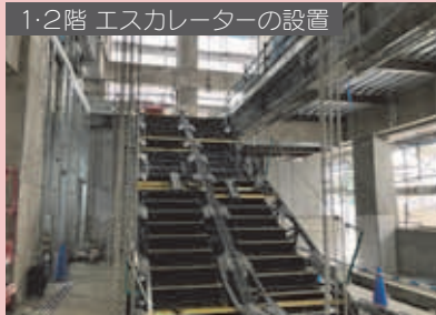
1・2階 エスカレーターの設置
