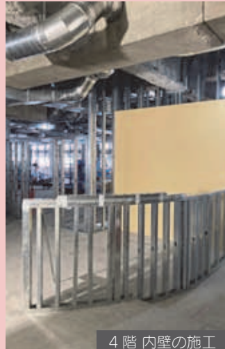
4階 内壁の施工
