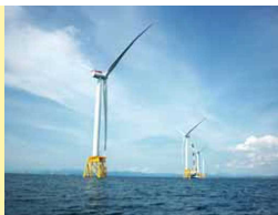
▲石狩湾新港洋上風力発電所（2024年1月運転開始）。写真は建設中のものである。
