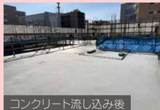
コンクリート流し込み後
