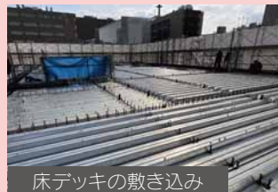
床デッキの敷き込み
