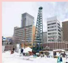
掘った部分に水がたまらないようにするため、井戸を作り、水中ポンプで地下水を吸い上げて排水します。
