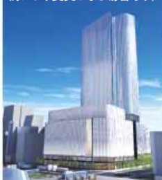
▲2028年度に工事が終わる予定の北4西3地区
