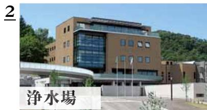
2 中央区に送られている水道水は主に藻岩浄水場でつくられています。24時間365日交代で、小さな濁りを固めて沈殿させ、細かい砂の層を通して汚れを取り除きます。さらに塩素で消毒して安全な水を送り出しています。
